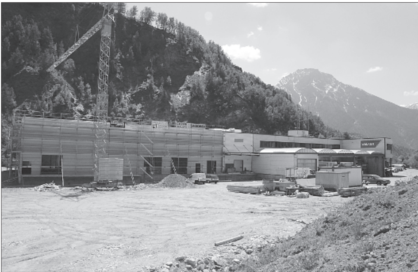
Die Walker Group geht ab dem 1. August mit der Howeg eine Kooperation ein. Zum gleichen Zeitpunkt wird die neue Lagerhalle, welche im Osten am bestehenden Gebäude entsteht, in Betrieb genommen. Fotos wb
